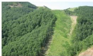
Комплекс противоэрозионных мероприятий на полосе отвода нефтегазопровода Сахалин-2 (92-102 км) Россия - Комплекс противоэрозионных мероприятий на полосе отвода нефтегазопровода Сахалин-2 (92-102 км)
